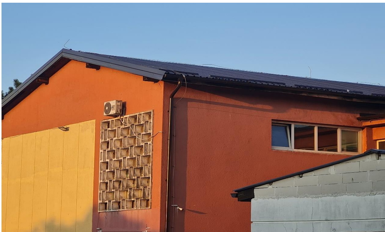
Реконструкција дела крова
